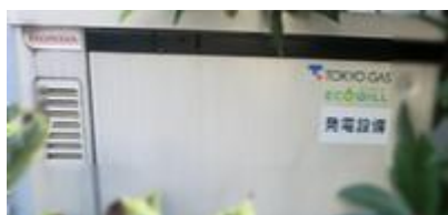
エコウィル 屋外の発電設備
